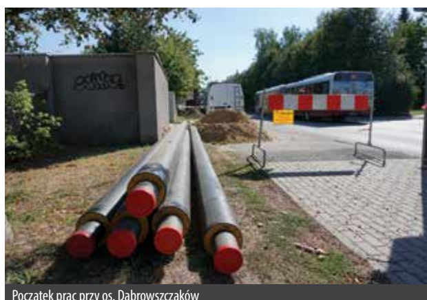
Początek prac przy os. Dąbrowszczaków
