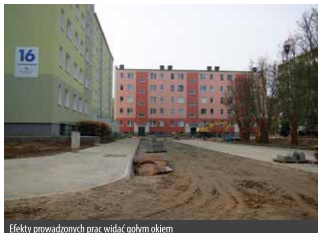
Efekty prowadzonych prac widać gołym okiem
