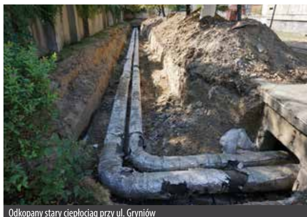
Odkopany stary ciepłociąg przy ul. Gryniów
