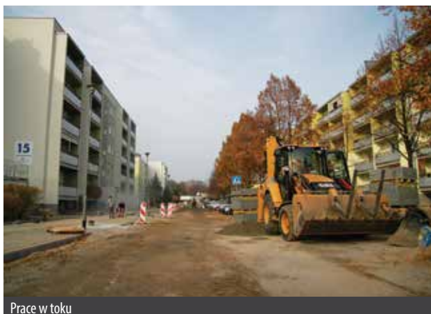
Prace w toku
